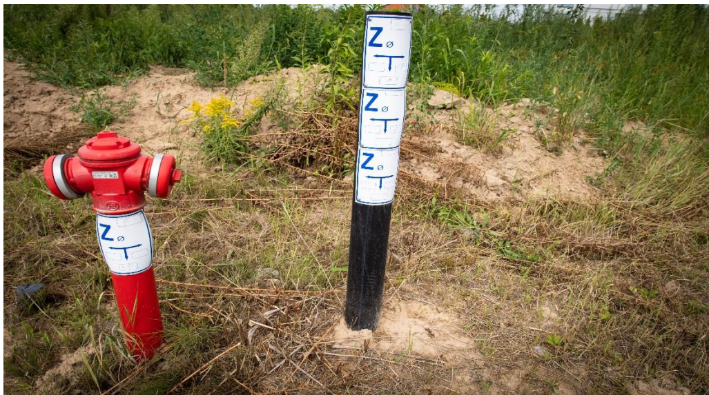
Lokalna infrastruktura wodociągów
