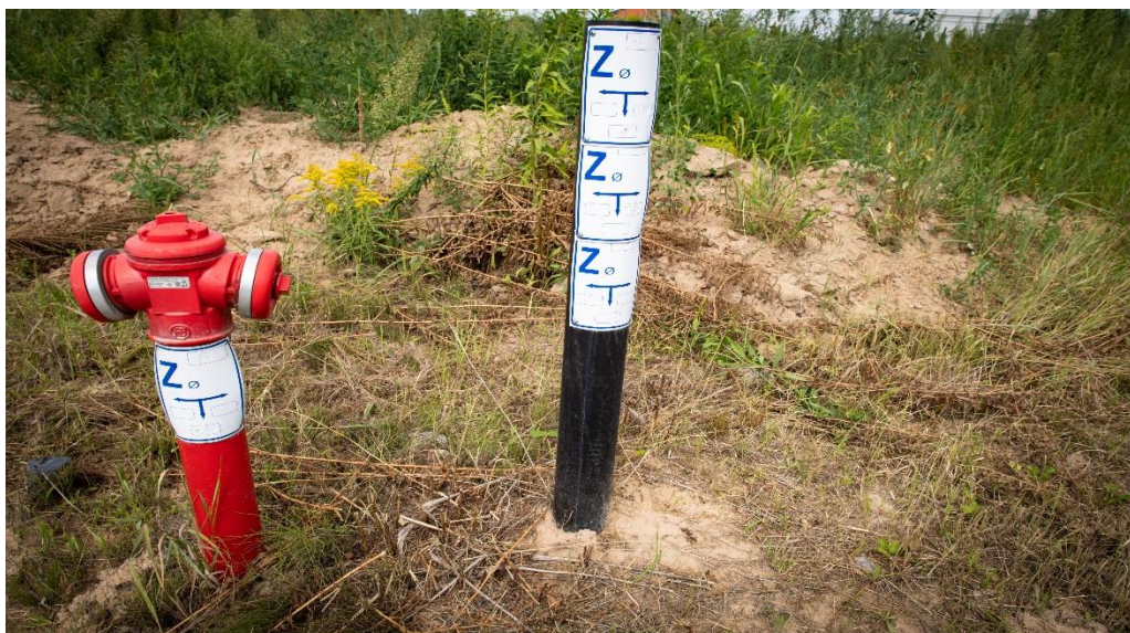
Lokalna infrastruktura wodociągów
